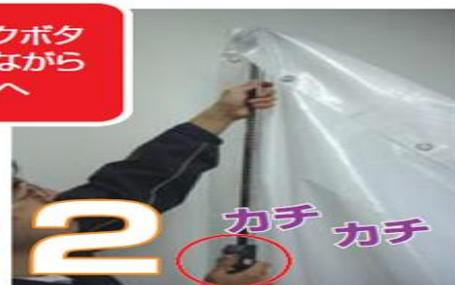
天井に到達したらバーを回転させ、定着するまで微調整します
